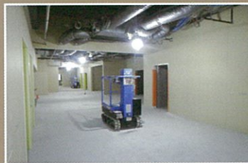
6階耐火壁 プラスターボード貼完了
